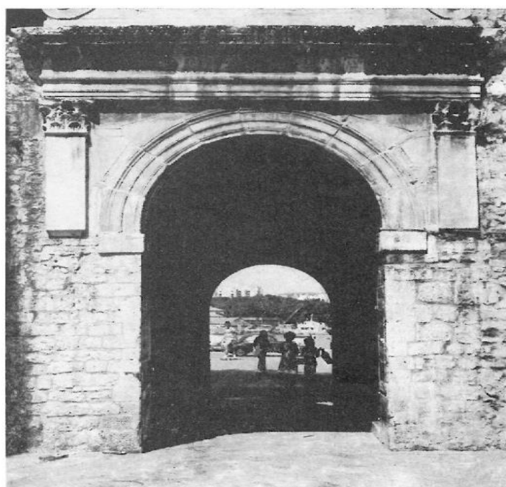
Unutarnja strana Morskih vrata s ugrađenim antičkim slavolukom (v. str. 200)
