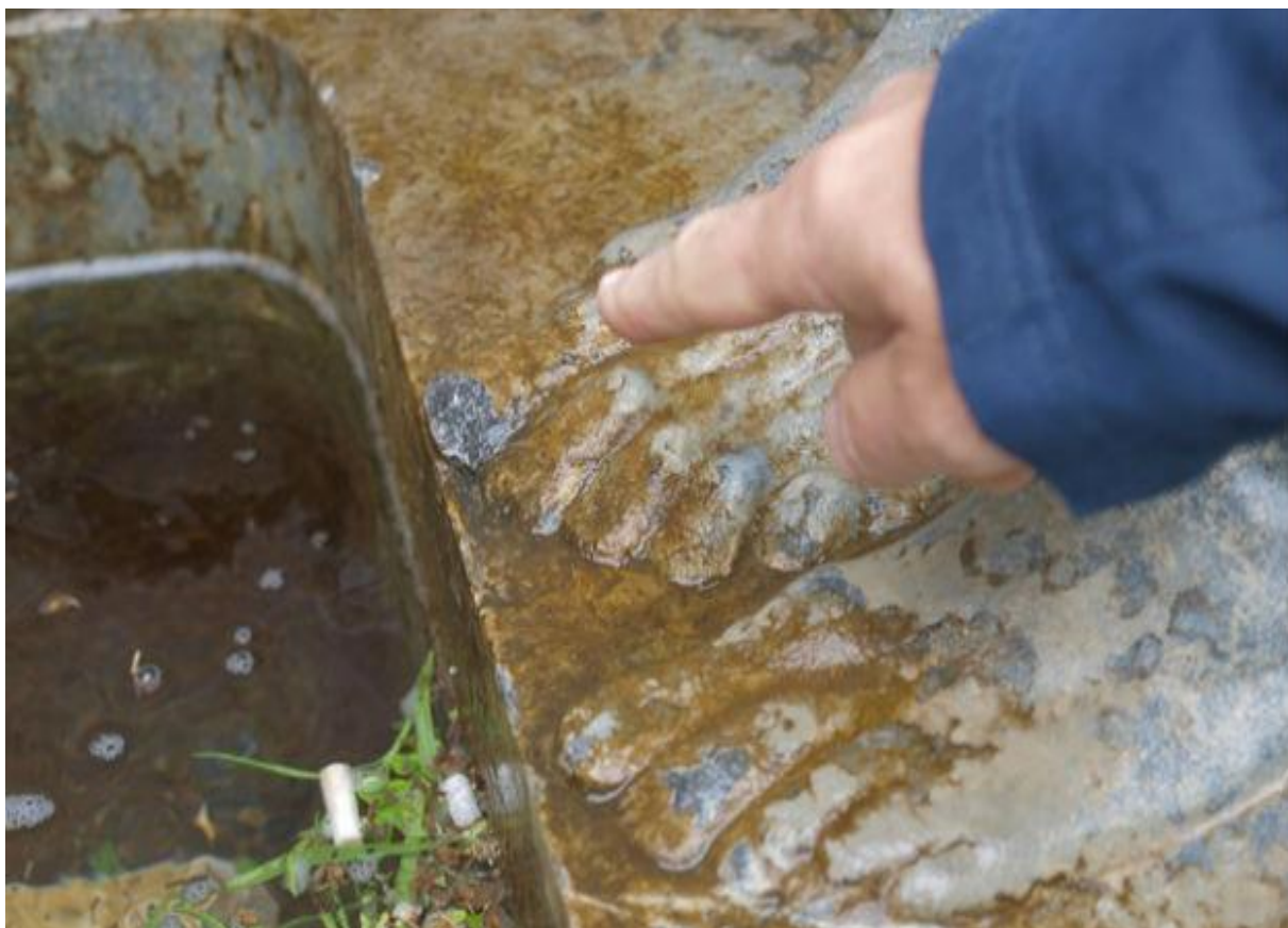
Sl. 125 Oštećenja na fontani Vrelo života nastala 2014. g. (Fototeka GMD)
