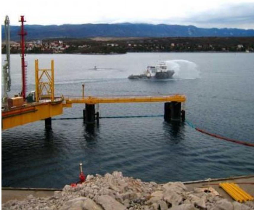
Slika 4. Vez u terminalu Omišalj
