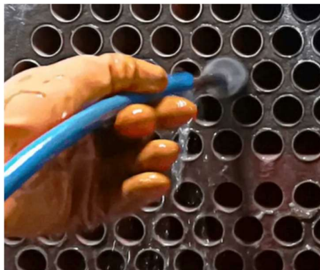
Slika 27. Prikaz čišćenja cijevnog izmjenjivača topline [26]
