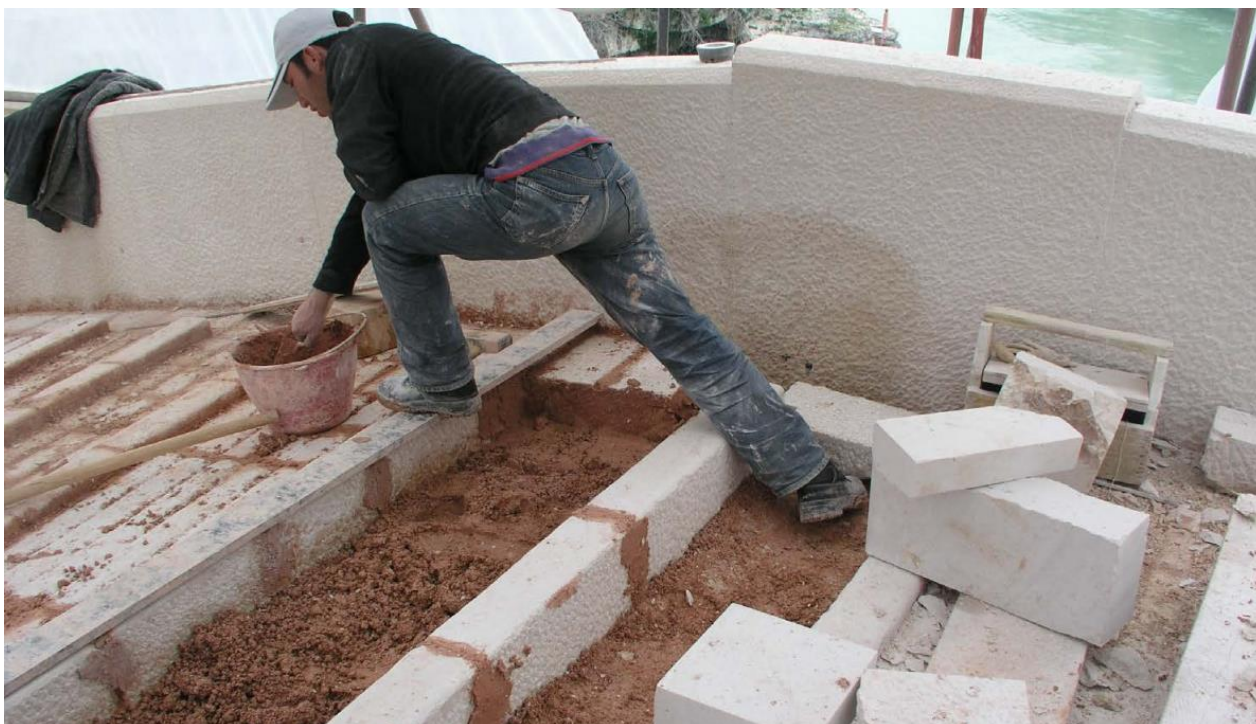
Slika 15. Prikaz popločanja kaldrme (Izvor: M. Glibić, Priče o Starom mostu, 2018., 61)
