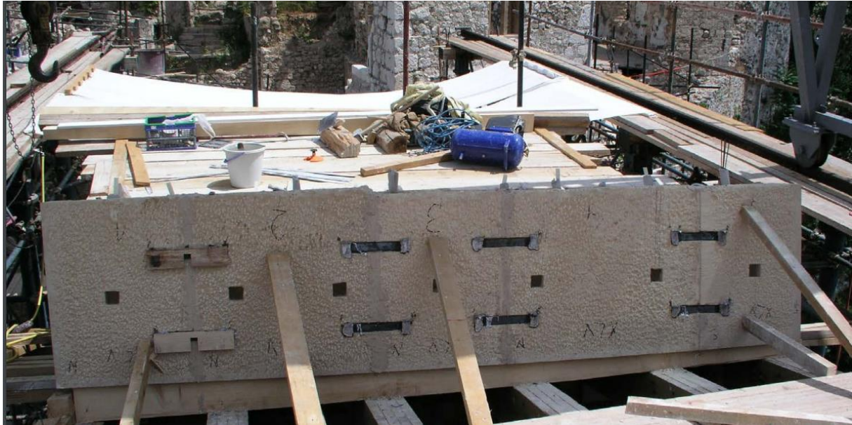
Slika 13. Pripremljeni kameni blokovi za zidanje luka Mosta (Izvor: M. Glibić, Priče o Starom mostu, 2018., 48)
