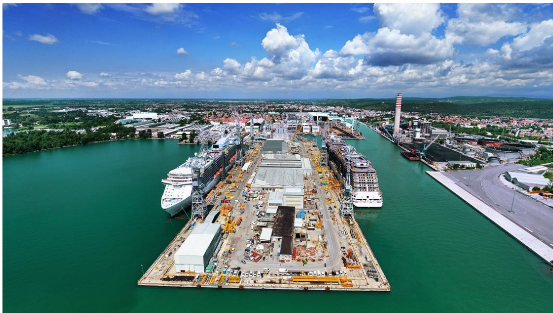
Slika 8. Brodogradilište Fincantieri u Trstu, Italija
