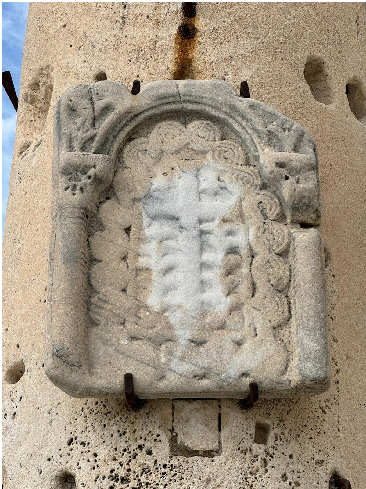
Slika 44. Prikaz oštećenog reljefa od soli na stupu srama
