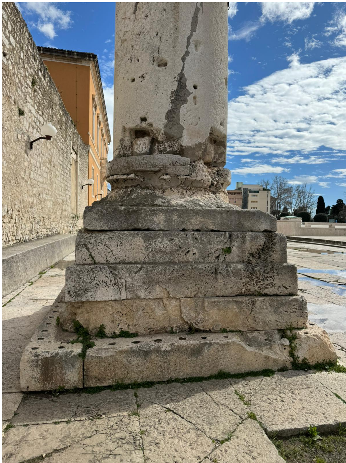
Slika 24. Prikaz stepenaste stube i baze kolone
