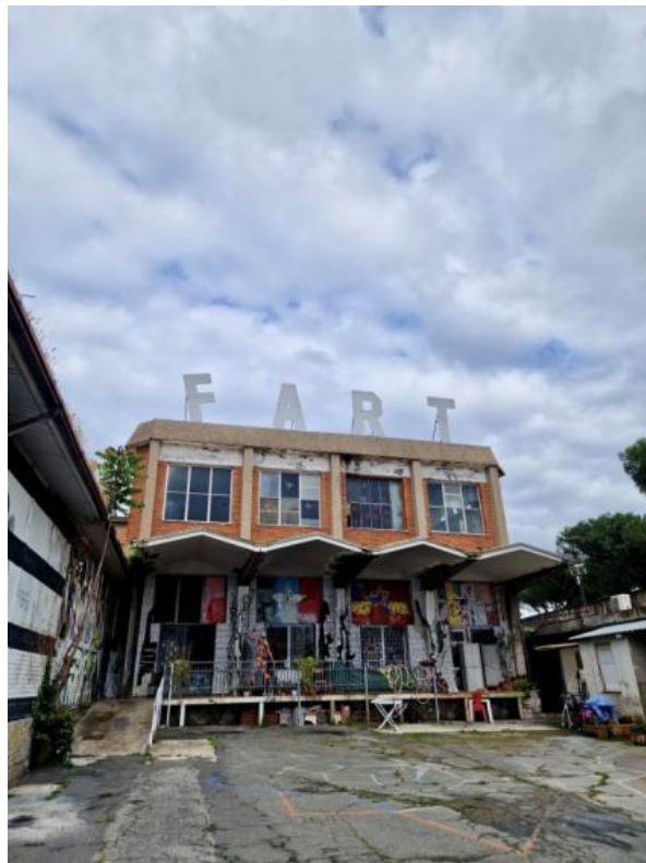
Slikovni prilog 3. Fotografija blok-zgrade s ulazom u MAAM . Autor fotografije je Josip Zanki.
