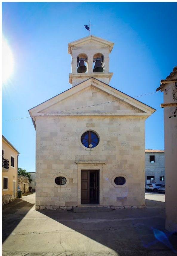
Slika 3. Crkva sv. Roka u Bibinjama, pogled na zapadno pročelje ( https://hikingarch.it/crkva-sv-rok-17531461072680834238/ )
