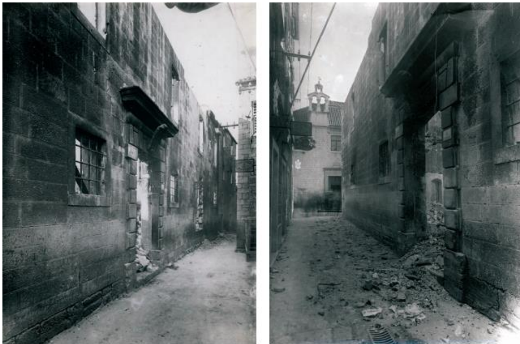
Sl. 77. Zgrada biskupije nakon požara 1924. godine (prema: Piplović, S. – Izgradnja Splita između svjetskih ratova)
