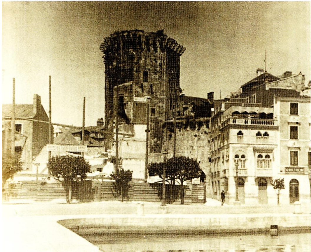
Sl. 98. Početak gradnje „Jadranske banke“ (prema: Belamarić, J. – Freud u Splitu)
