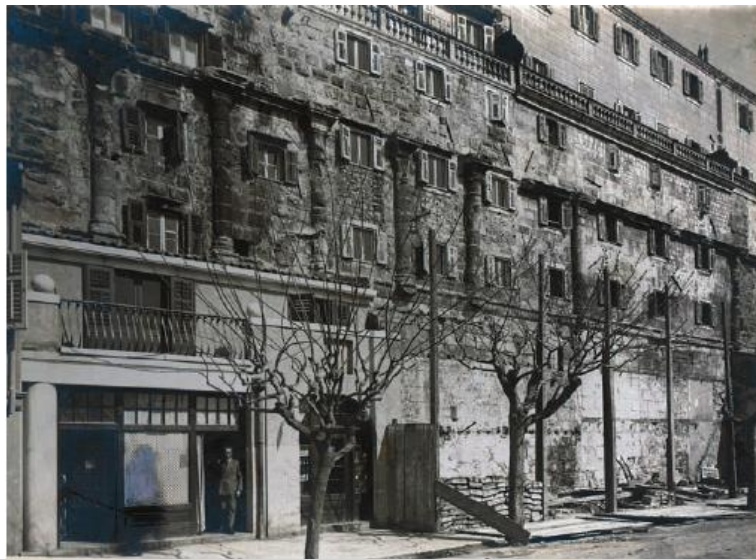
Sl. 97. Početak gradnje novih kućica prema projektu Alfred Kellera (prema: Piplović, S. – Uređenje povijesne jezgre Splita između svjetskih ratova)
