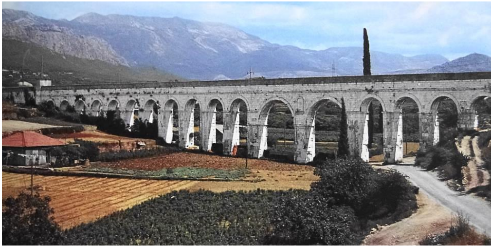
Sl. 44. Dioklecijanov vodovod nakon obnove (prema: www.splitskerazglednice.net )
