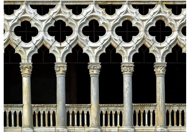
Slika 173. Balustrada palače Ca`d`Oro (1428.-1430.), Giovanni i Bartolomeo Bon
