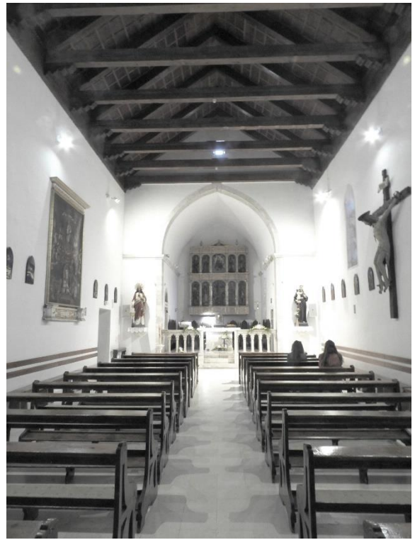
Slika 26. Drvena stropna konstrukcija poljudske crkve
