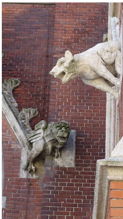
Prilog 17. Obnovljeni i neobnovljeni detalji konkatedrale na sjevernom pročelju. Autor fotografije: Karla Buzinac.
