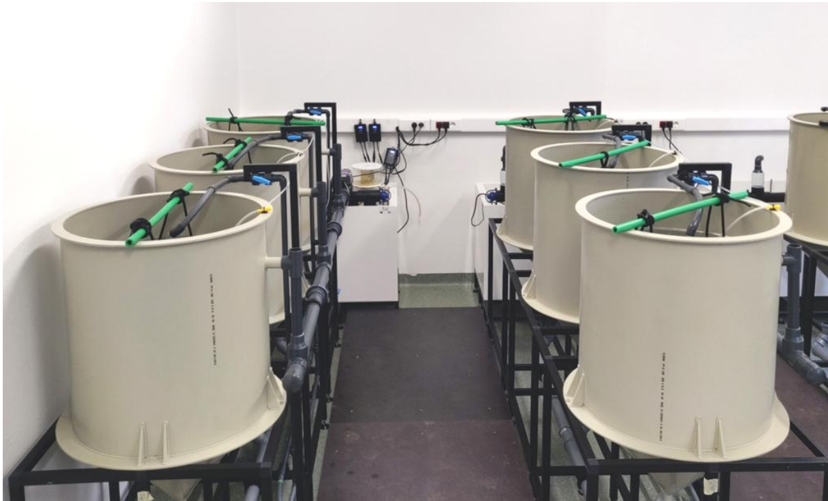
Slika 3. Uzgojni bazeni u recirkulacijskom sustavu (Autor: Marija Brkić)
