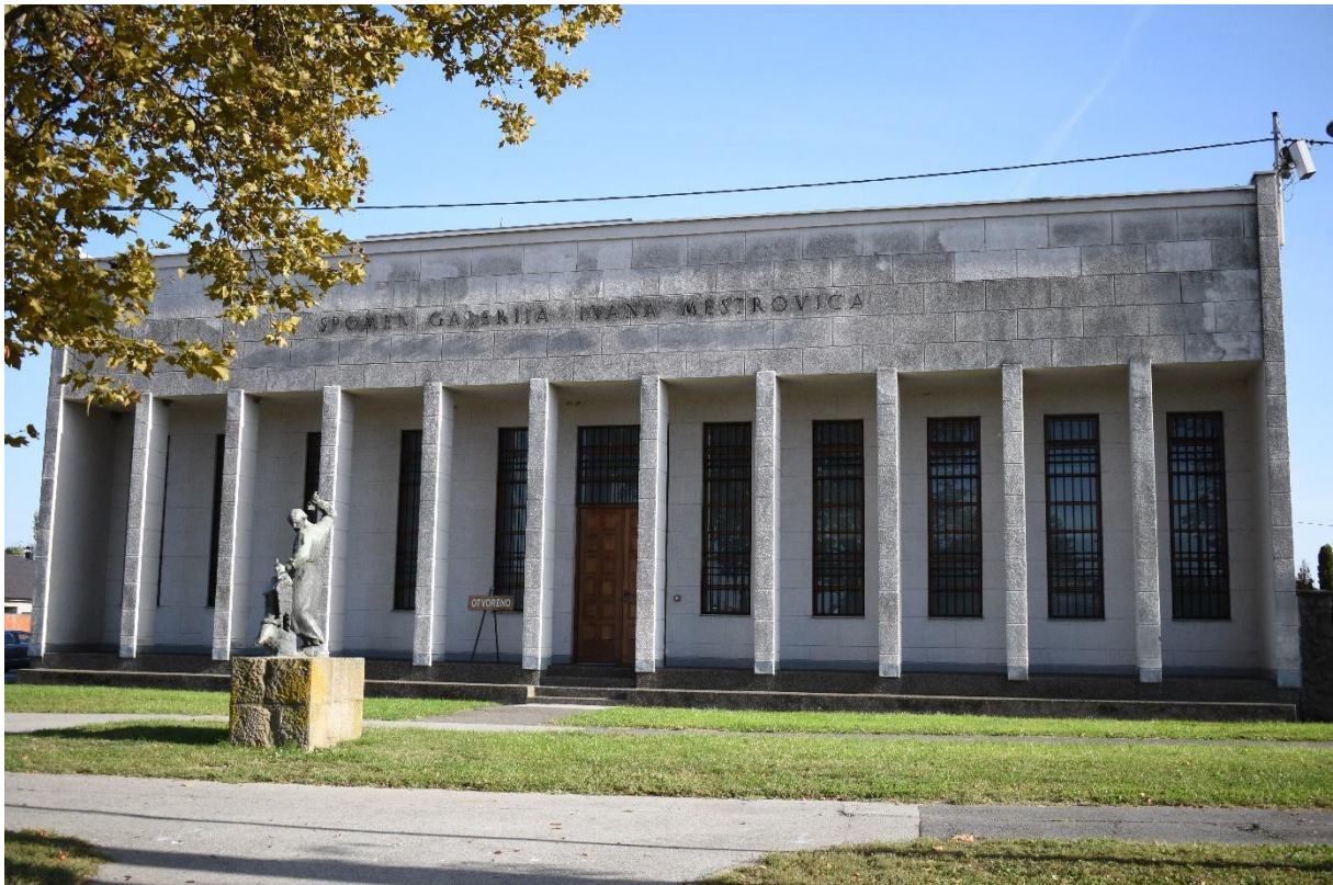
Slika 32 Fotografija sjevernog pročelja (Izvor: Kristina Slobodanac)
