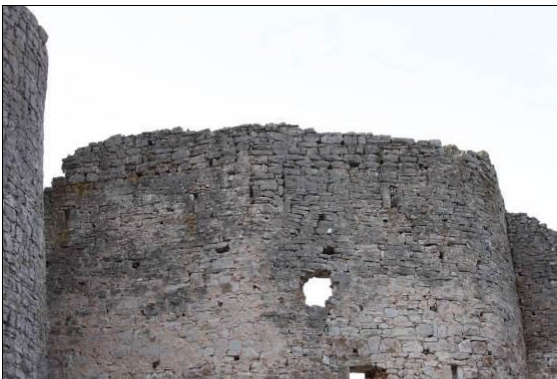
Slika 19. Glavaš, zazidano krunište
