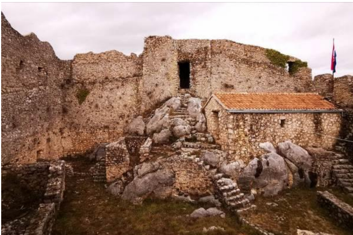
Slika 127. Vrgorac - unutrašnjost tvrđave i pogled na sjeverni bedem s kulom
