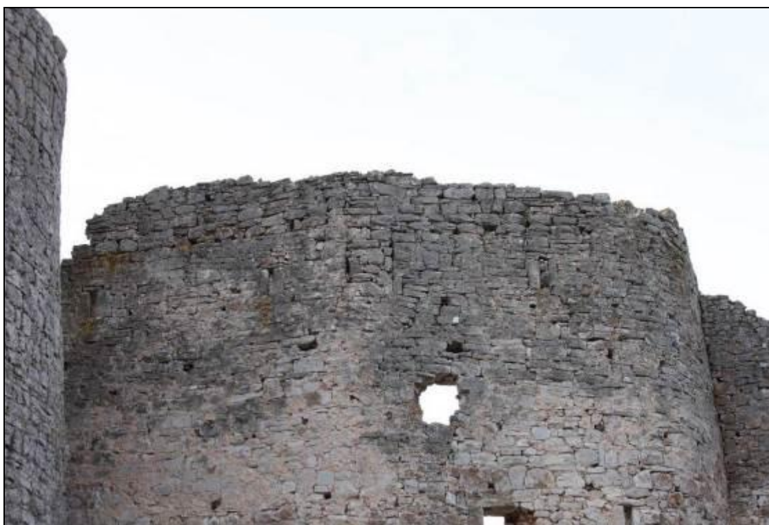
Slika 19. Glavaš, zazidano krunište
