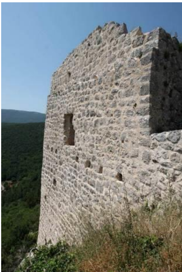
Slika 36. Vrlika – Prozor, otvori za grede koje su nosile hourd
