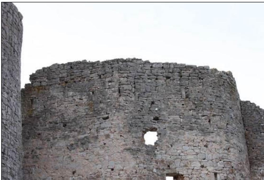
Slika 19. Glavaš, zazidano krunište
