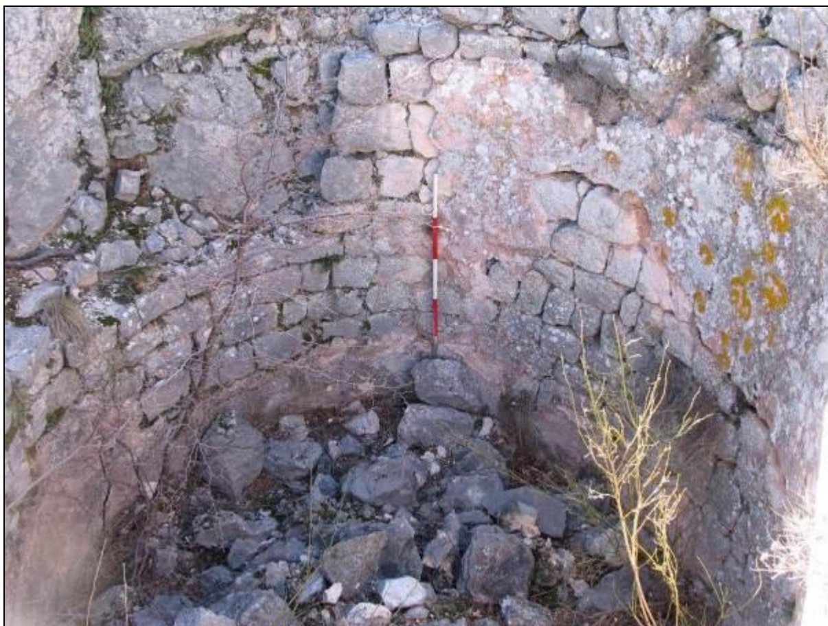
Slika 92. Proložac – Badnjevice, cisterna za vodu
