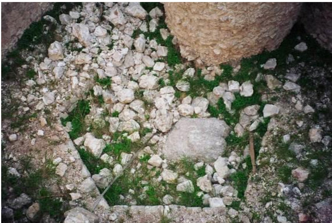
Slika 63. Čačvina, unutrašnjost kule – šesterokutni temelji ranije kule
