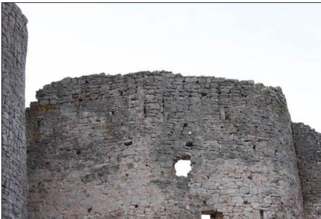
Slika 19. Glavaš, zazidano krunište
