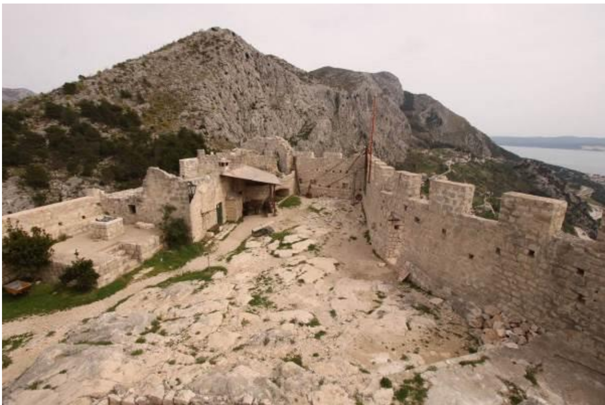
Slika 120. Starigrad - donji dio tvrđave s dvorištem, kućom i cisternom za vodu
