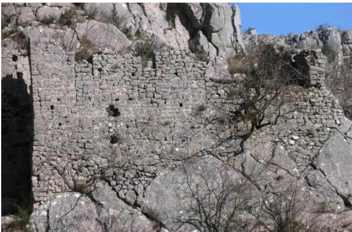
Slika 89. Proložac – Badnjevice, zazidano krunište na drugom bedemu
