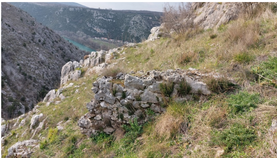
Sl. 156. Ostatci zida u malteru u podnožju Gradine sa zapadne strane Gradine (foto: Ž. Pandža)
