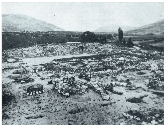
Sl. 77. Gospodarska zgrada nakon iskopavanja 1903.; iz dokumentacije C. Patscha (preuzeto: Bojanovski, 1969a, 40)
