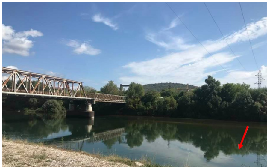
Sl. 218. Položaj mogućeg prijelaza preko Neretve sjevernije od Željezničkog mosta (foto: Ž. Pandža)
