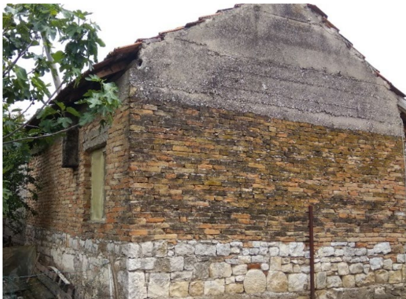
Sl. 269. Seoska kuća (zidovi) na Kućištu izgrađeni oko 1963. godine od opeka preuzetih iz rimske vile (foto: Ž. Pandža)
