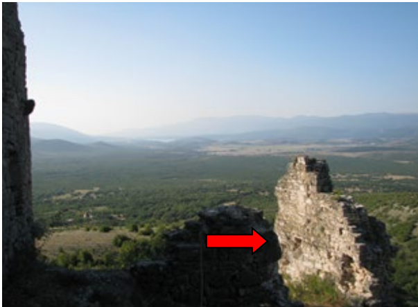
Sl. 87. Zid SJ 12 Prostorije 1 na zapadu utvrde
