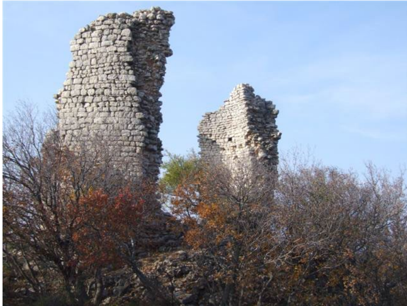
Sl. 156. Pogled s jugozapada na utvrdu Zečevo
