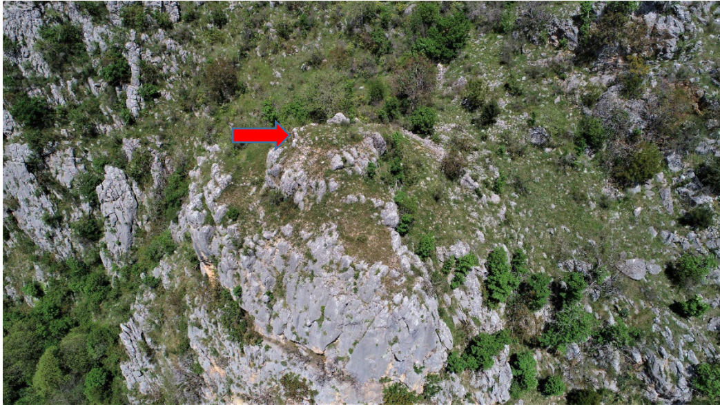
Sl. 391. Pogled iz zraka na ostatak zida na južnoj strani (foto: Joško Zaninović, 2021.)
