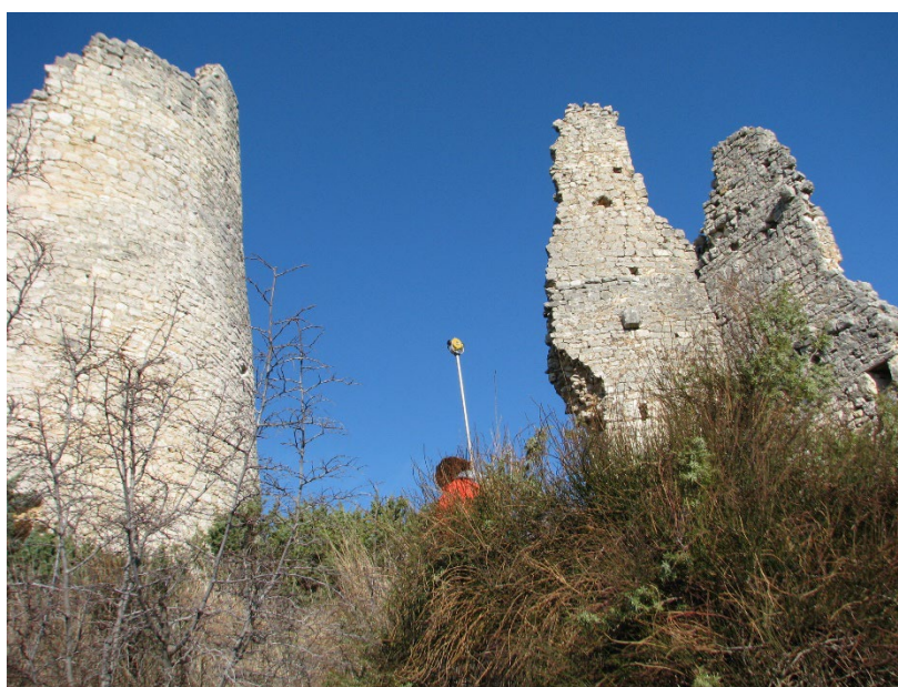
Sl. 139. Pogled s jugozapada na kružnu kulu na zapadu i ostatak dvaju zidova zgrade na sjeveru i sjeverozapadu utvrde
