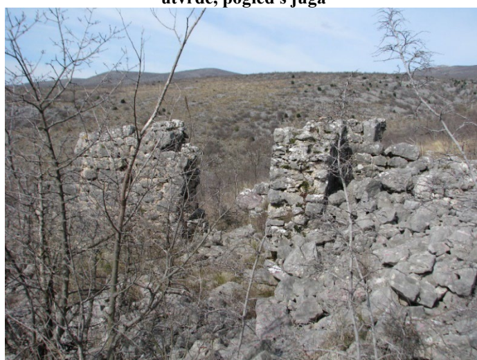
Sl. 284. Ulaz unutar obrambenog zida na sjeverozapadnoj strani utvrde, pogled s juga
