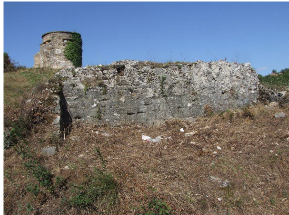
Sl. 186. Pogled na kvadratičnu kulu smještenu na južnoj strani Kapitula
