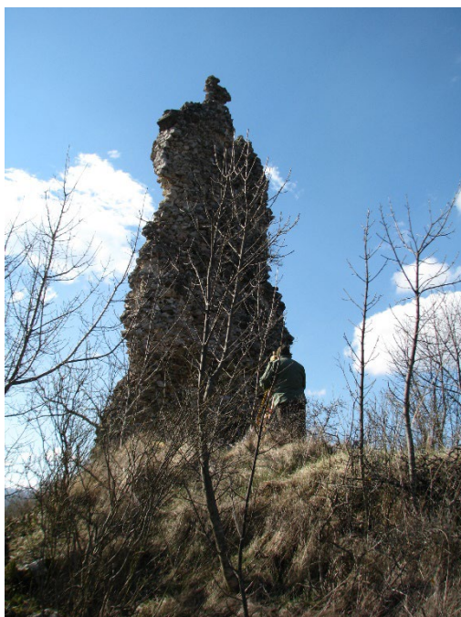
Sl. 404. Pogled s jugozapada na južni zid pravokutne kule
