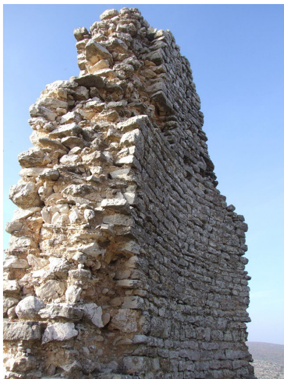
Sl. 160. Pogled s juga na jugozapadni zid utvrde
