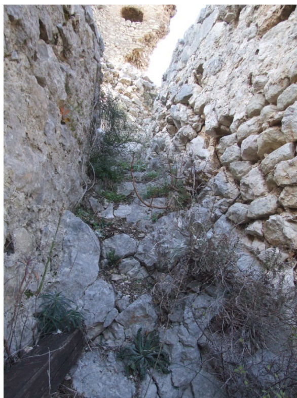
Sl. 42a. Kamene stepenice kojima se pristupalo u utvrdu iz pravca kružne kule
