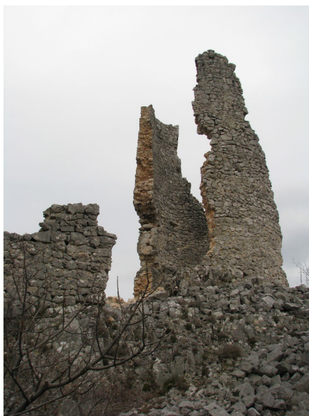
Sl. 376. Pogled na jugozapadni obrambeni zid utvrde i ostatke kružne kule (?) (17. studenoga 2015.)
