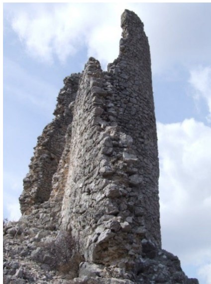
Sl. 383. Pogled s jugoistoka na obrambeni zid inkorporiran u kružnu kulu (19. ožujka 2010.)
