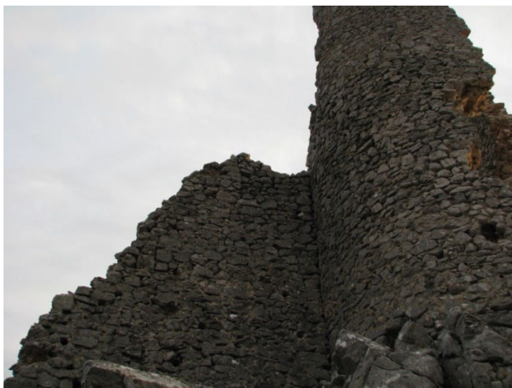
Sl. 384. Pogled sa sjeveroistoka na obrambeni zid inkorporiran na kružnu kulu (19. ožujka 2010.)
