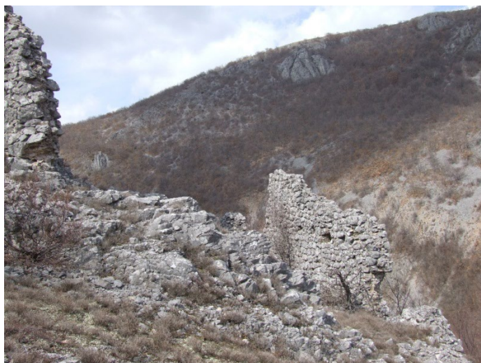
Sl. 385. Pogled na ostatke obrambenog zida na istočnoj strani utvrde (19. ožujka 2010.)
