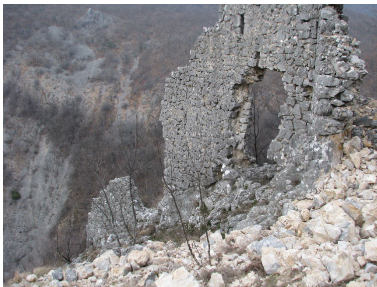
Sl. 377. Orambeni zid na jugozapadu utvrde (17. studenoga 2015.)
