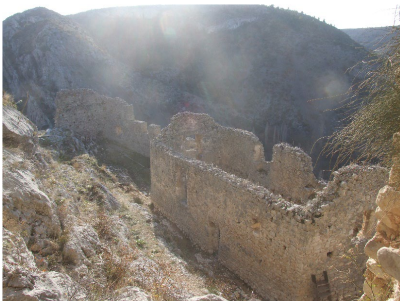
Sl. 50. Obrambeni zid na jugozapadnoj i južnoj strani utvrde
