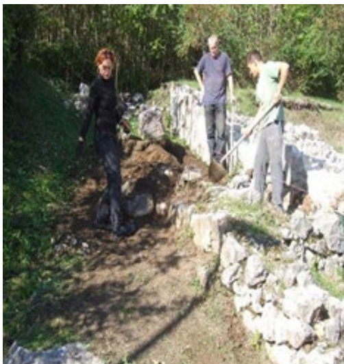
Sl. 261. Pogled s juga na zid SJ 3 prije radova konzervacije
