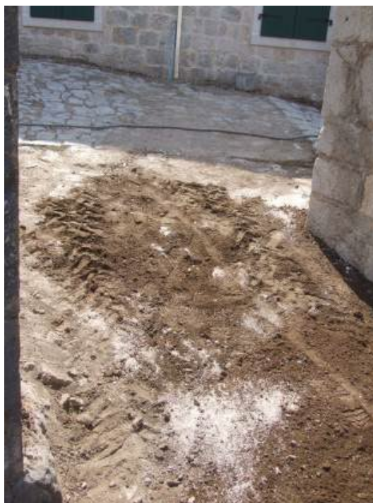
Sl. 225. Nasipanje zemlje preko konzervirane staze kako bi se staza dodatno učvrstila
