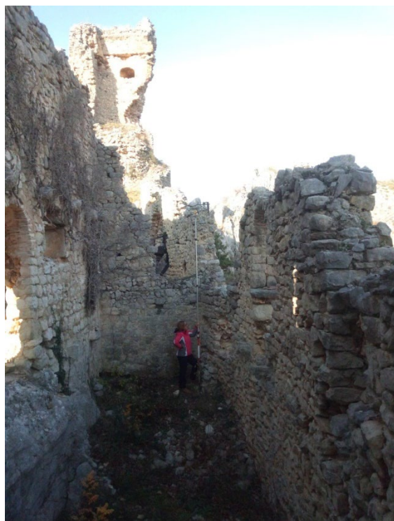
Sl. 53. Horizontalno mjerenje obrambenog zida na sjeveroistočnoj strani prostorije
