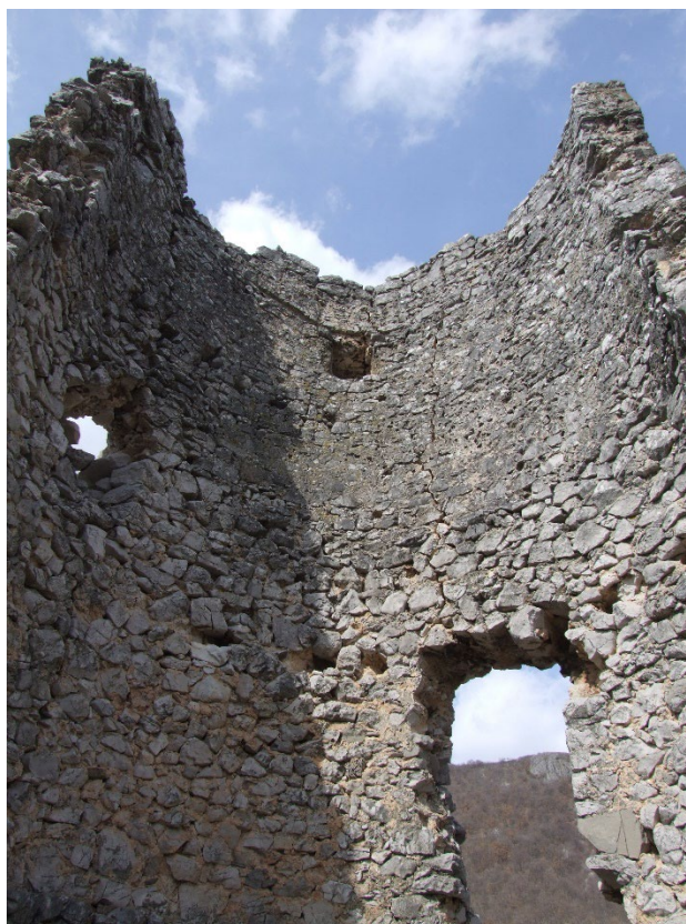
Sl. 369. Ostaci otvora za grede u kružnoj kuli (19. ožujka 2010.)
