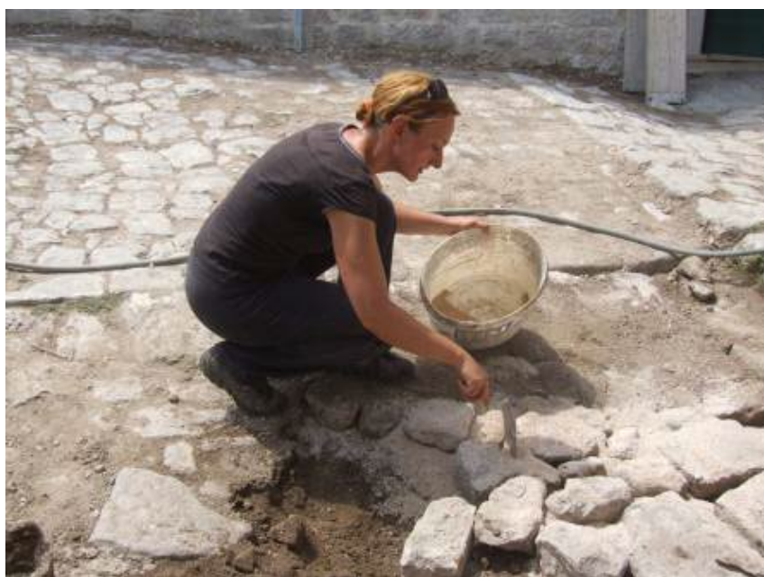
Sl. 224. Postupak vraćanja kamena na stazu i uranjanje kamena u kamenu nulu
