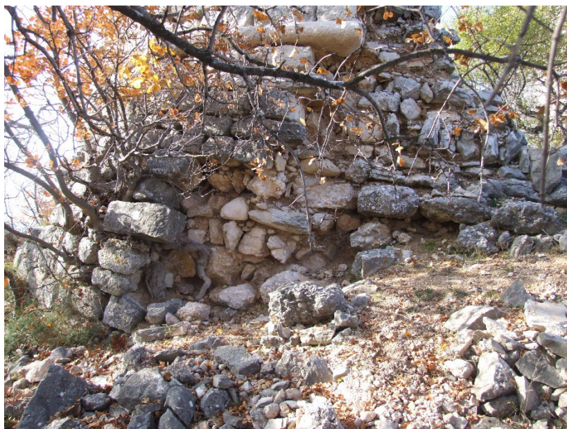
Sl. 162. Pogled na temeljnu stopu na zidu kule na jugozapadu utvrde
