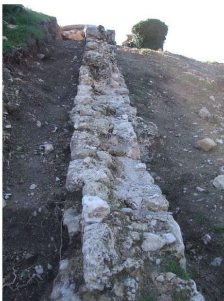
Sl. 183. Pogled sa sjevera na obrambeni zid
