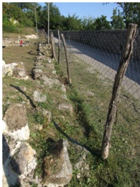
Sl. 263. Pogled s juga na zid SJ 5 prije radova konzervacije
