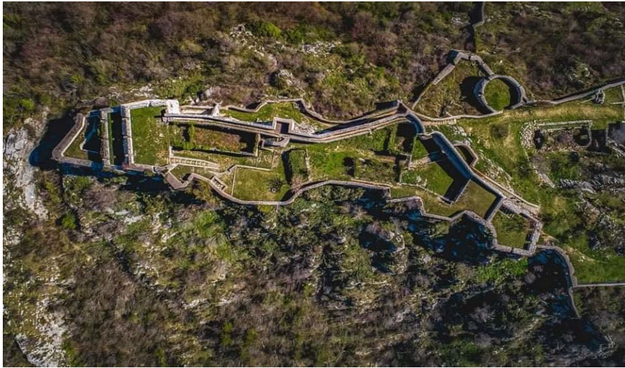
Sl. 496. Izgradnja obrambenih zidova u 18. stoljeću (foto: Neven Rogić, 2019.)
