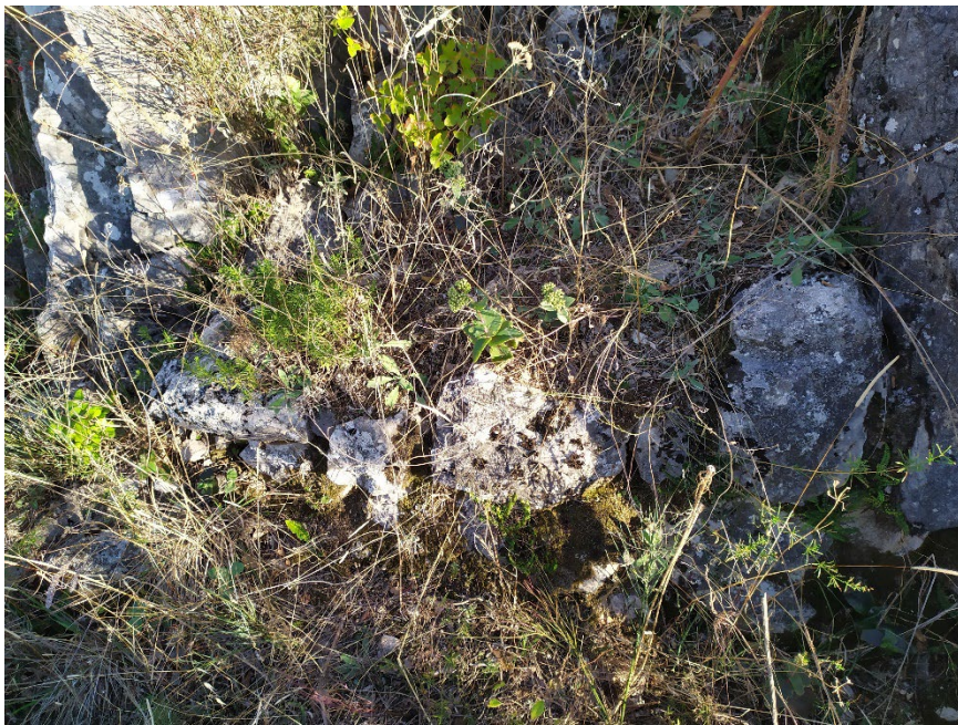
Sl. 394. Ostatak zida na zapadnoj strani
