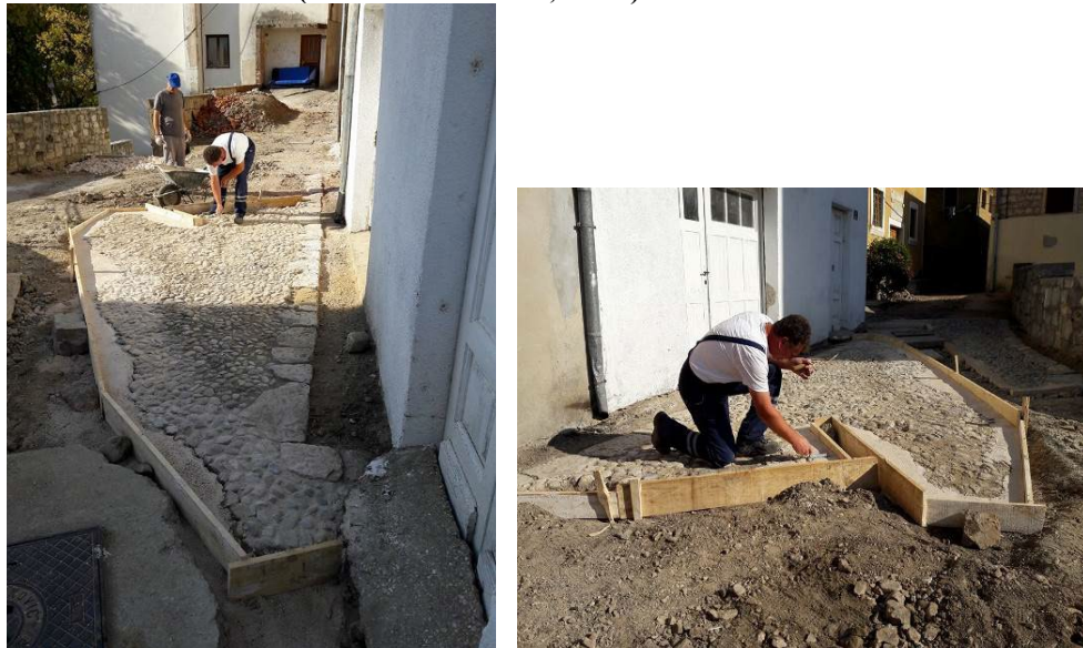
Sl. 278. a - b Provođenje radova konzervacije na drugom dijelu popločenja (kaldrme) (foto: Miloš Biserko, 2017.)
