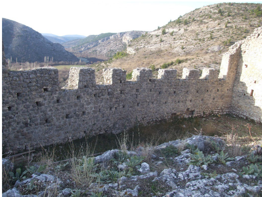
Sl. 49. Orambeni zid utvrde na jugozapadnoj strani utvrde
