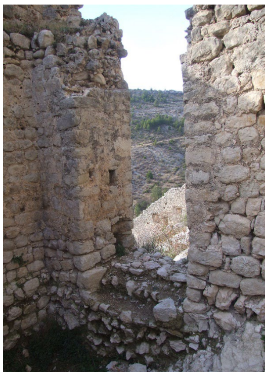
Sl. 47. Ulaz na jugozapadnoj strani utvrde
