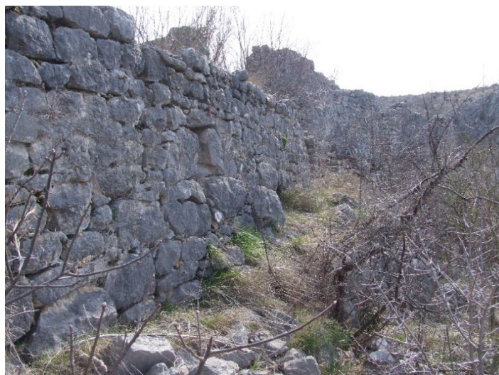
Sl. 282. Obrambeni zid sa sjeverozapadne strane utvrde, pogled sa sjevera
