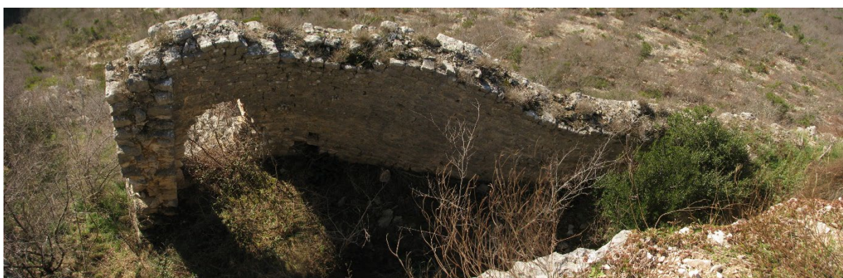
Sl. 143. Obrambeni zid na južnoj strani utvrde
