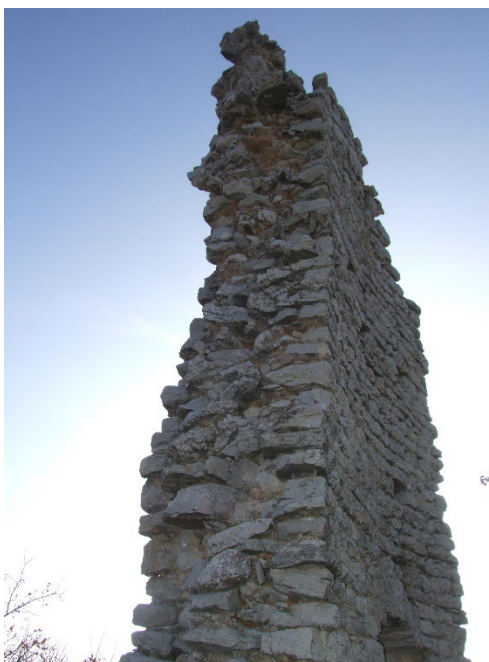
Sl. 164. Pogled s istoka na jugoistočni zid utvrde
