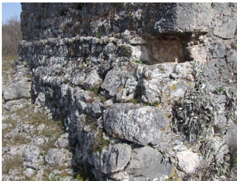
Sl. 5. Pogled na sjeveroistočni zid i ojačanje temeljne stope utvrde
