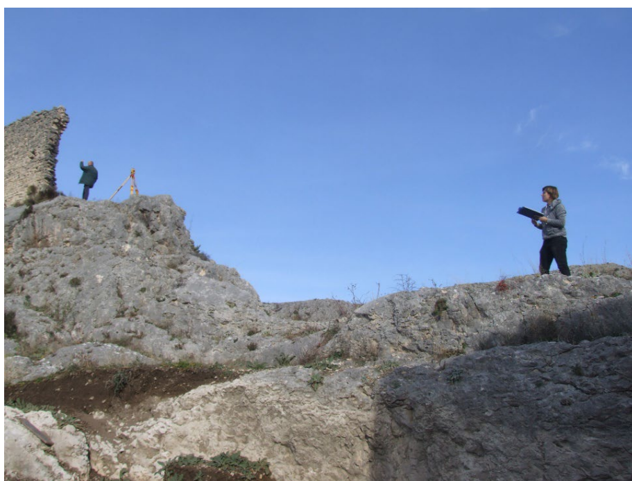
Sl. 51. Obrambeni zid na istočnoj strani utvrde
