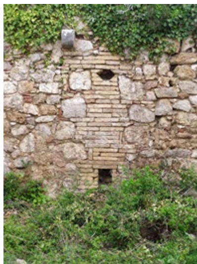
477. Dimnjak u zgradi vojarne
