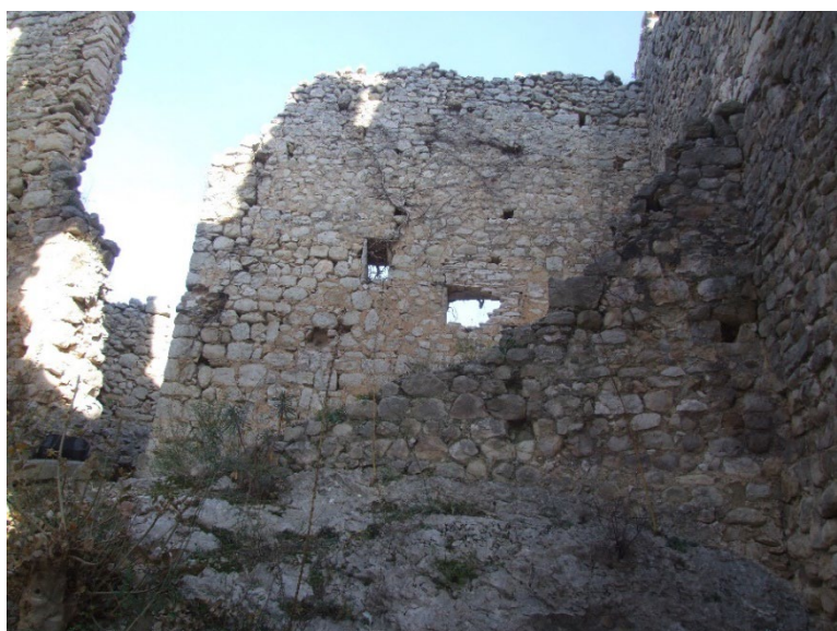
Sl. 41. Zid sa sjeverozapadne strane prostorije
