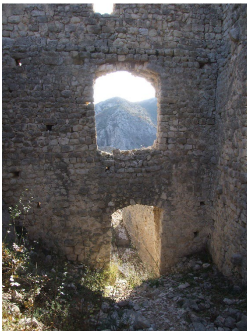
Sl. 44. Pogled iz prostorije na ulaz s južne strane
