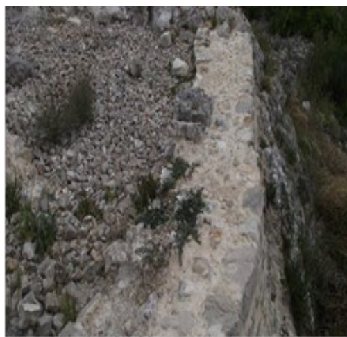
Sl. 127. Pogled sa zapada na zid SJ 10 poslije konzervatorskih radova
