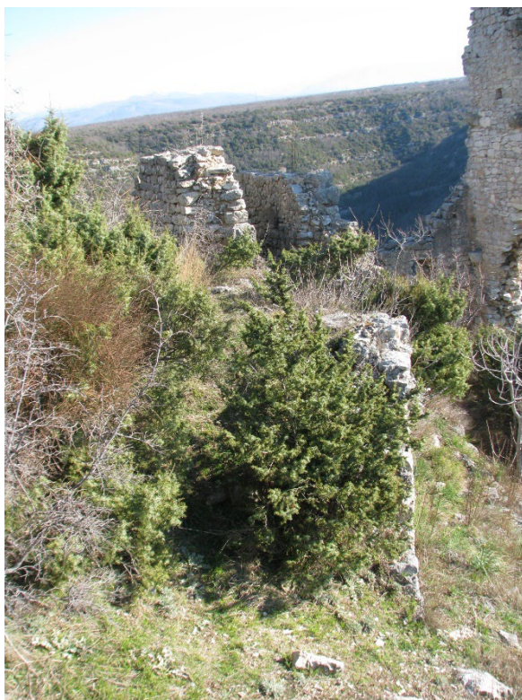
Sl. 142. Manji obrambeni zid ispred zgrade na sjeveroistoku utvrde
