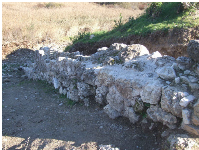
Sl. 187. Na ostatak obrambenog zida sa sjeveroistočne strane Kapitula stavljen je završni sloj žbuke kako bi se zid zaštitio od propadanja
