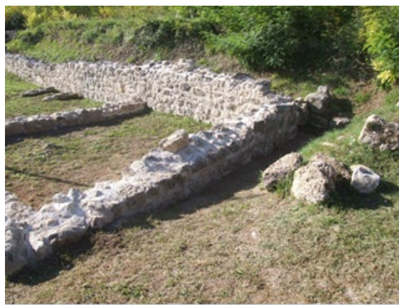
Sl. 266. Pogled s istoka na zid SJ 6 poslije radova konzervacije
