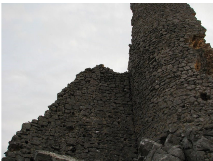
Sl. 384. Pogled sa sjeveroistoka na obrambeni zid inkorporiran na kružnu kulu (19. ožujka 2010.)
