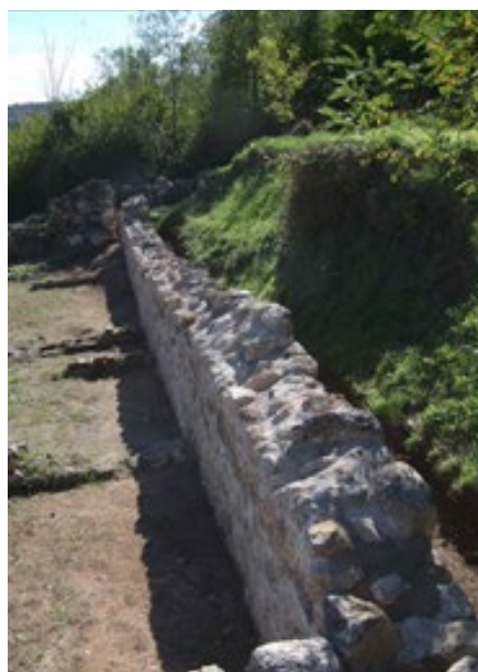
Sl. 258. Pogled sa sjevera na zid SJ 1 nakon radova konzervacije
