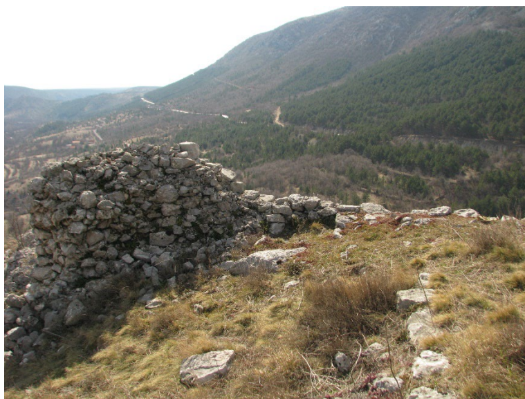
Sl. 352. Ostatak obrambenog zida na jugozapadnoj strani
