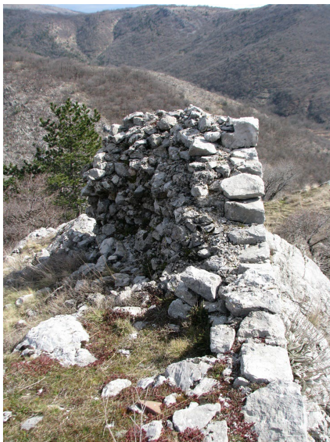
Sl. 353. Dio zida na sjeverozapadnoj strani
