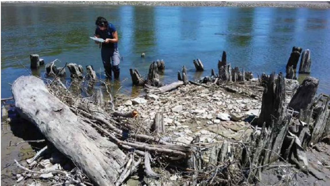
Slika 8. Dokumentiranje drvene konstrukcije (M. PEŠIĆ, 2017, 31.).
