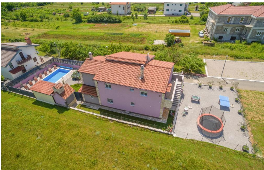
Slika 25. Smještajni objekti - općina Hrvace
