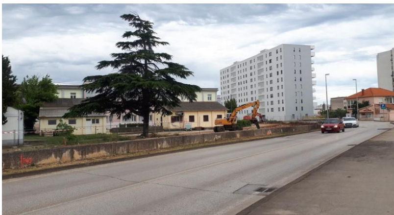
Slika 10. Obešumljenje na prostoru Tuđmanove ulice
