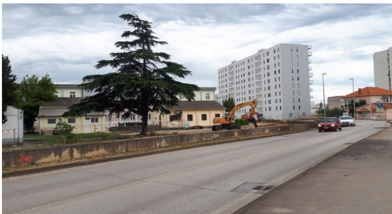
Slika 10. Obešumljenje na prostoru Tuđmanove ulice
