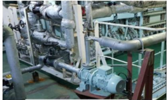
Slika 16. Protustrujna pumpna jedinica[8]
