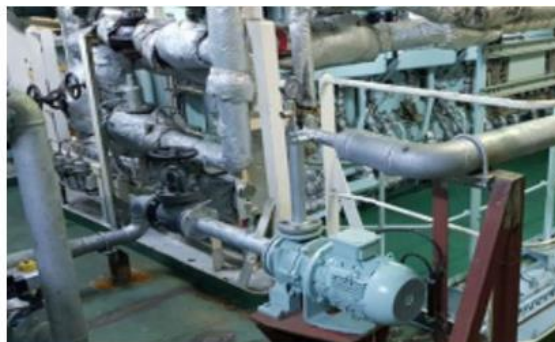
Slika 16. Protustrujna pumpna jedinica[8]
