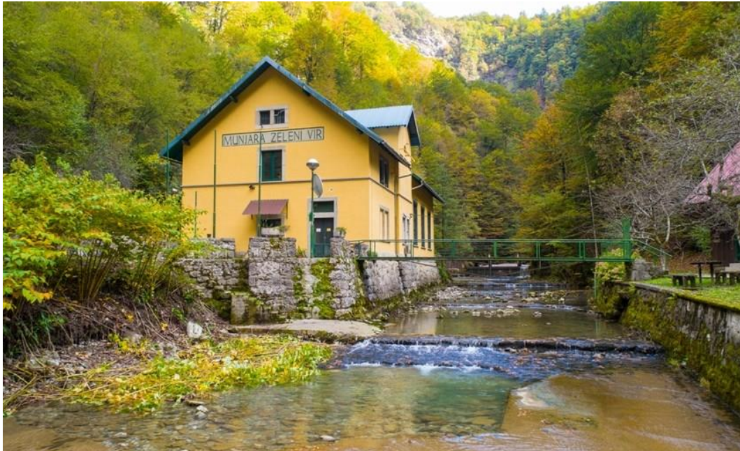
Slika 29. Hidroelektrana „Zeleni Vir“ Izvor: HEP (pretraživano: 4.10.2023.)
