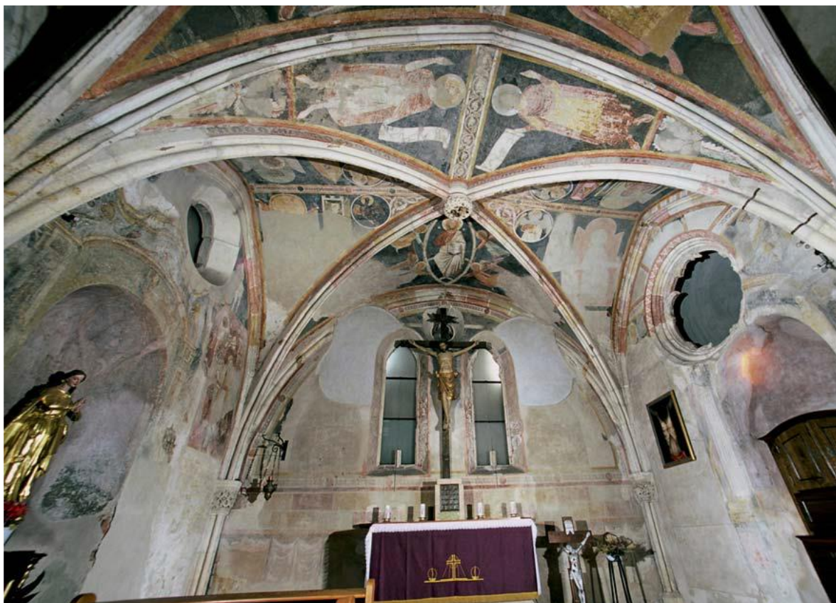
Prilog 15. Fotografija, zatečeno stanje kapele svetog Stjepana u Zagrebu - pogled na svod i južni zid. Izvor: I. SRŠA, 2010. – Ivan Srša, Pitanje prezentacije fragmentarno očuvanih srednjovjekovnih zidnih slika, Peristil , 53 (2010.), str. 127-144
