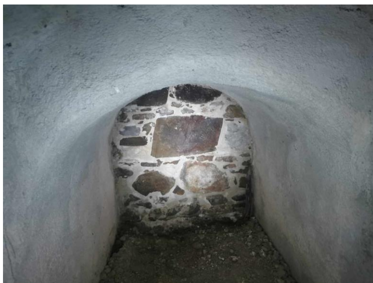
Slika 31. Zazidani ulaz u tunel (foto: L. Bajt)
