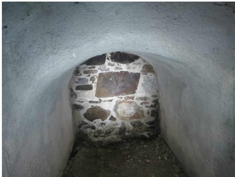
Slika 31. Zazidani ulaz u tunel (foto: L. Bajt)
