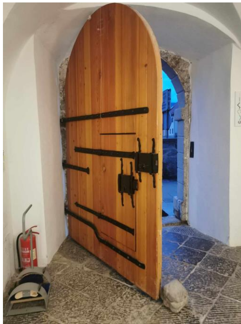
Slika 33. Originalna vrata s pomoćnim ulazom (foto: L. Bajt)
