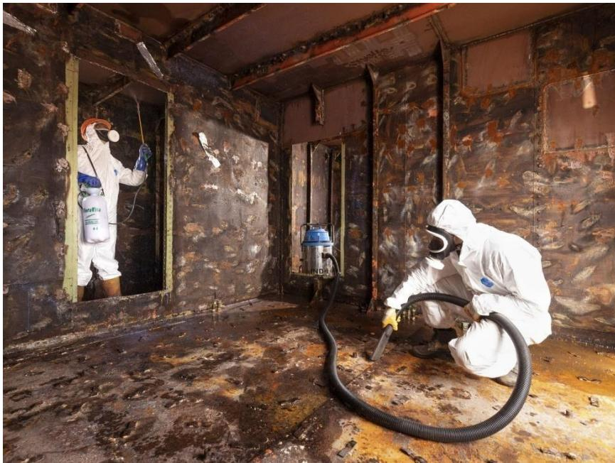
Slika 1. Pravilna sigurnosna oprema prilikom uklanjanja azbesta s broda
