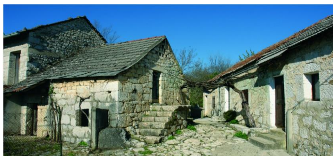
Slika 10. Primjer starih runovičkih kuća
