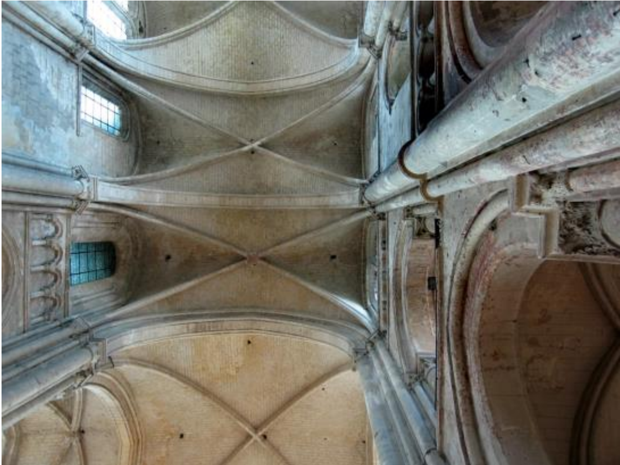
Slika 11. Svod katedrale Notre-Dame u Noyonu s vidljivim šupljinama u koje su umetane akustične posude
