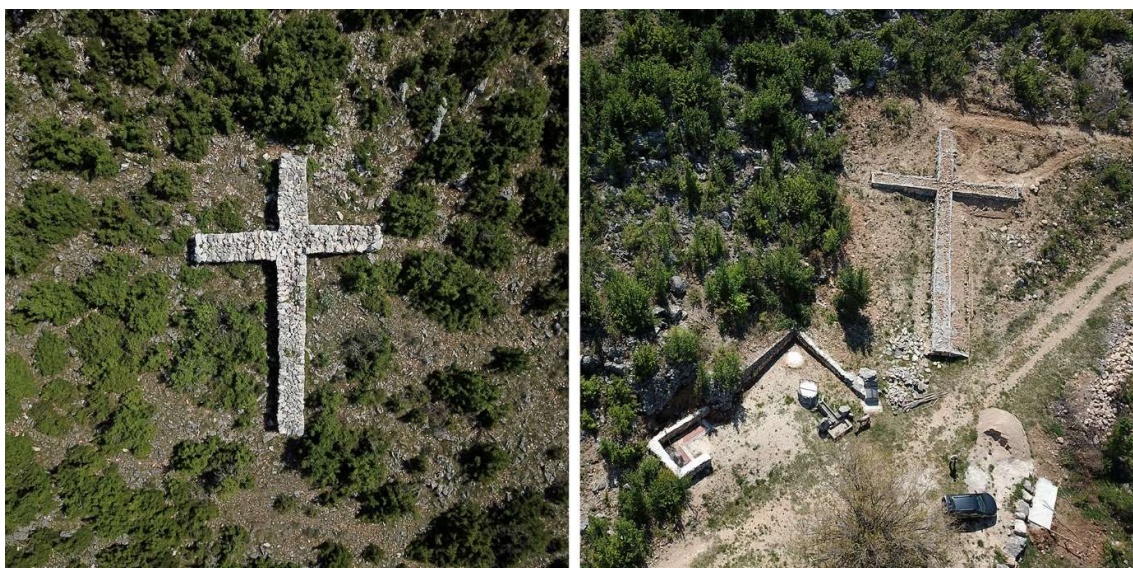
Slike 101-102. Križevi na Gradinici u Bilišanima i Osojnici u Kruševu (snimio I. Kulenović)
