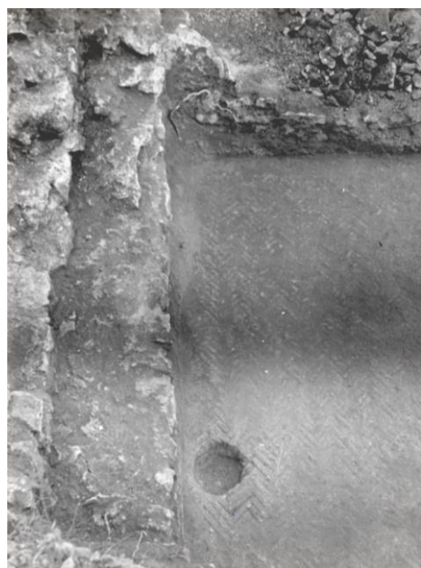
Sl. 73. Biograd – položaj Kumenat, Segment manje cisterne smještene u jugoistočnom dijelu kompleksa (Fototeka ZM Biograd na Moru, br. negativa 2377, Foto: B. JURAGA, 1981.)
