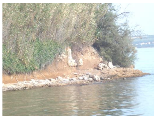
Sl. 38. i 39. Tkon – položaj Poljane, Ostatci perimetralnog zida vidljivog u profilu obale (Foto: M. JURJEVIĆ)
