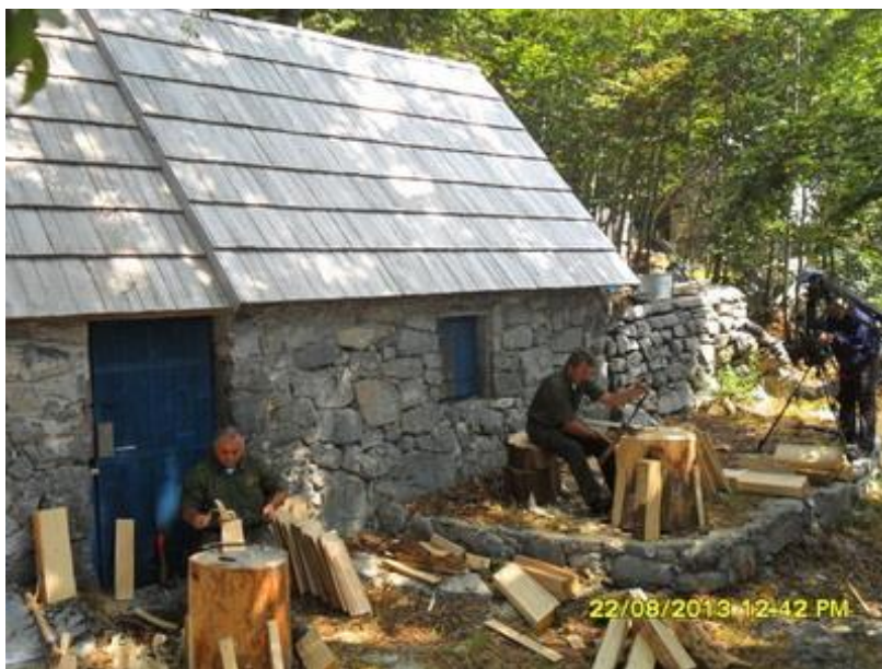
Slika 4. Izrada drvene šindre
