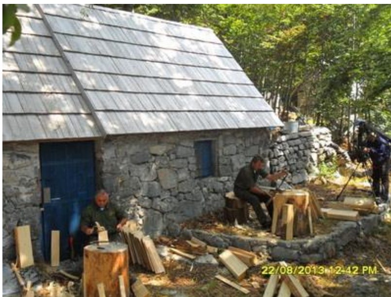
Slika 4. Izrada drvene šindre
