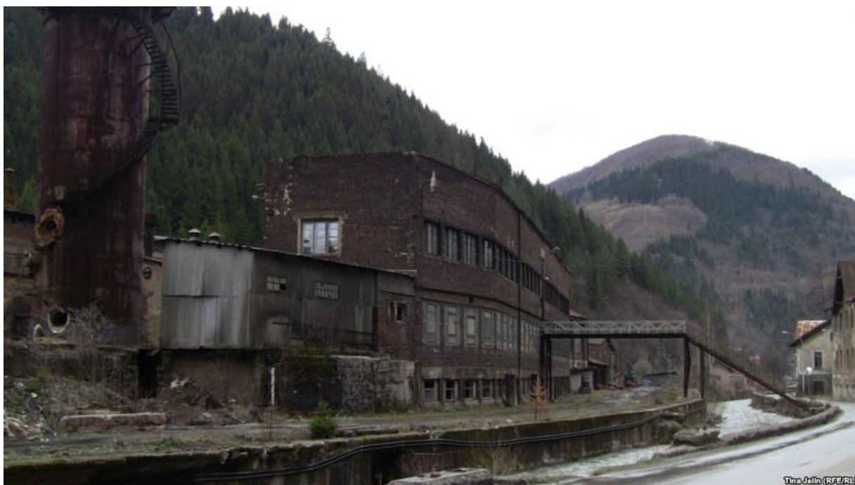
Slikovni prilog 2. Fotografija nekadašnje tvornice i djela gradilišta.
