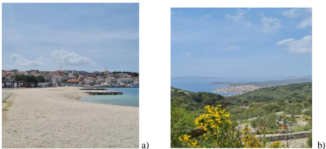
Slika 27. Gusta izgradnja u naselju Okrug Gornji (a,b)
