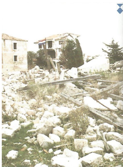
Slika 39. Škabrnja- Župna crkva Uznesenja BDM. (Ranjena crkva u Hrvatskoj, 1996: 306).
