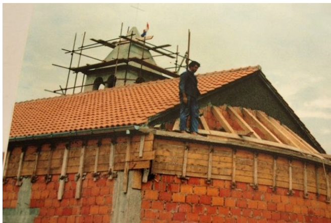
Slika 11. Izgradnja crkve Duha Svetoga u Podgradini. (Internetski izvor 10.)
