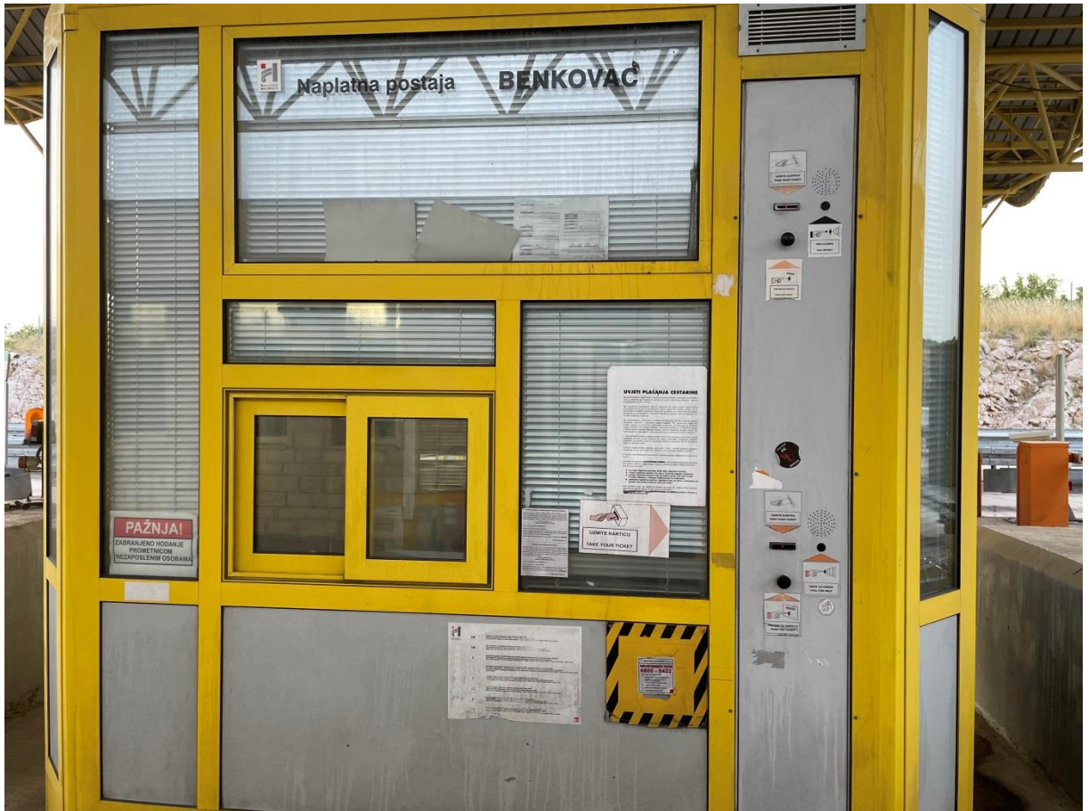
Slika 9 Ulazna staza s automatiziranim davačem magnetskih kartica
