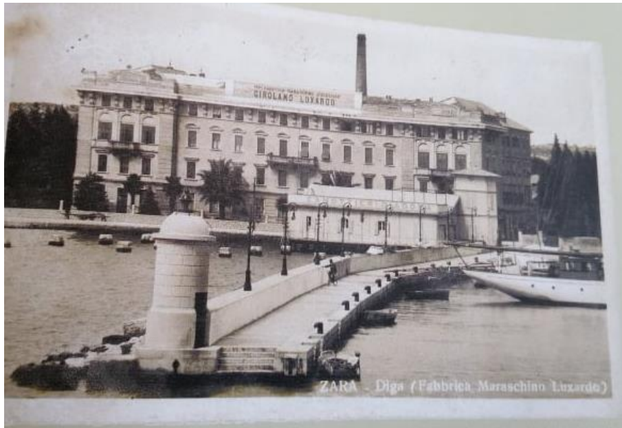
Slika 20. Nova zgrada tvornice likera obitelji Luxardo smještena na Brodarici (Seferović, Šuljak, 2005.)
