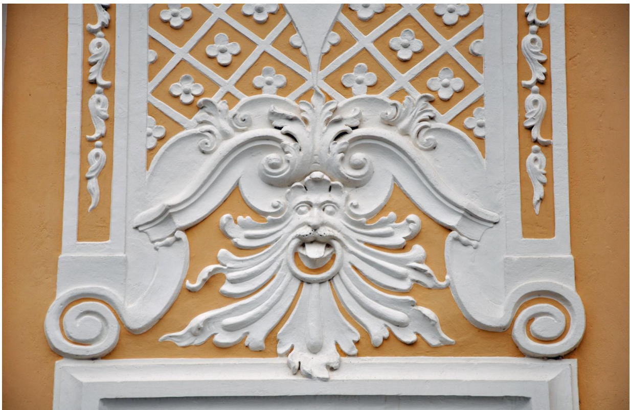
Slika 8. Dvorac Schielleiten, Schielleiten, 1717. – 1731., detalj štukove dekoracije (foto: A. Laznibat)
