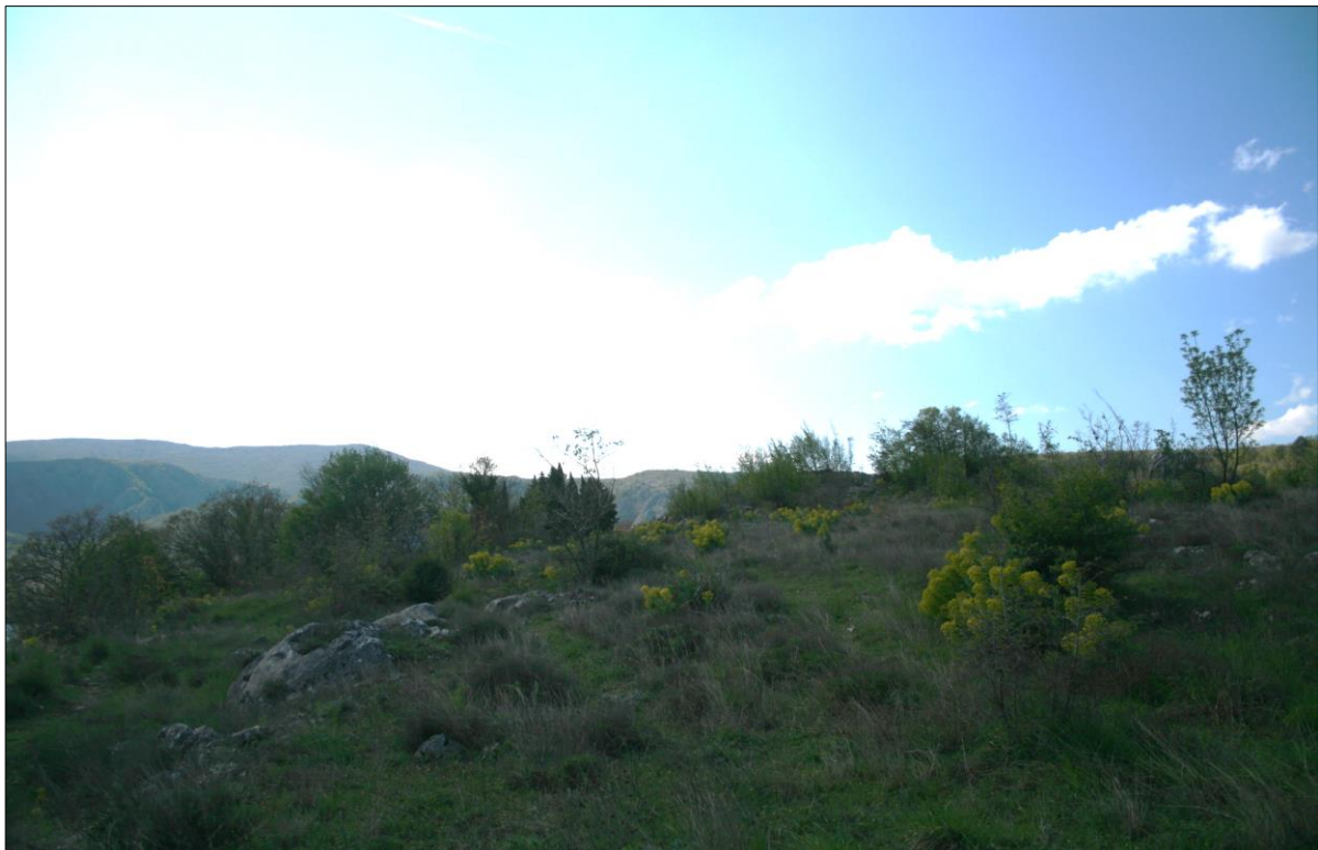
Sl. 115 – 117. Zaravnjeni vrh zapadnog bedema, suvremena komunikacija probijena kroz zapadni bedem, pogled na plato gradine (foto. T. Tomas)
