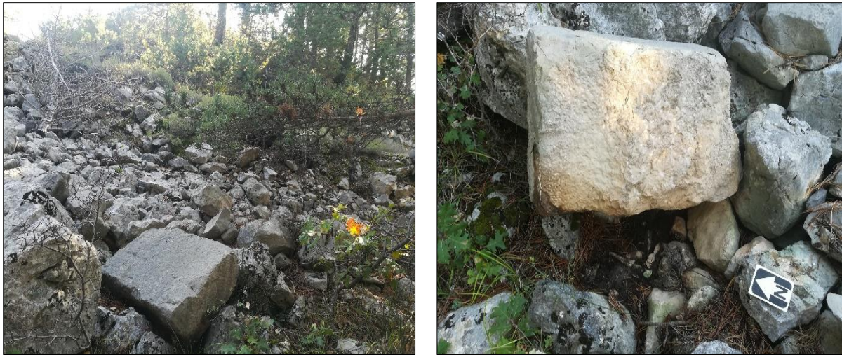
Sl. 109 – 110. Veći, pravilno oklesani kameni blokovi s izraženom bunjom, na sjevernom dijelu bedema akropole (foto: T. Tomas)
