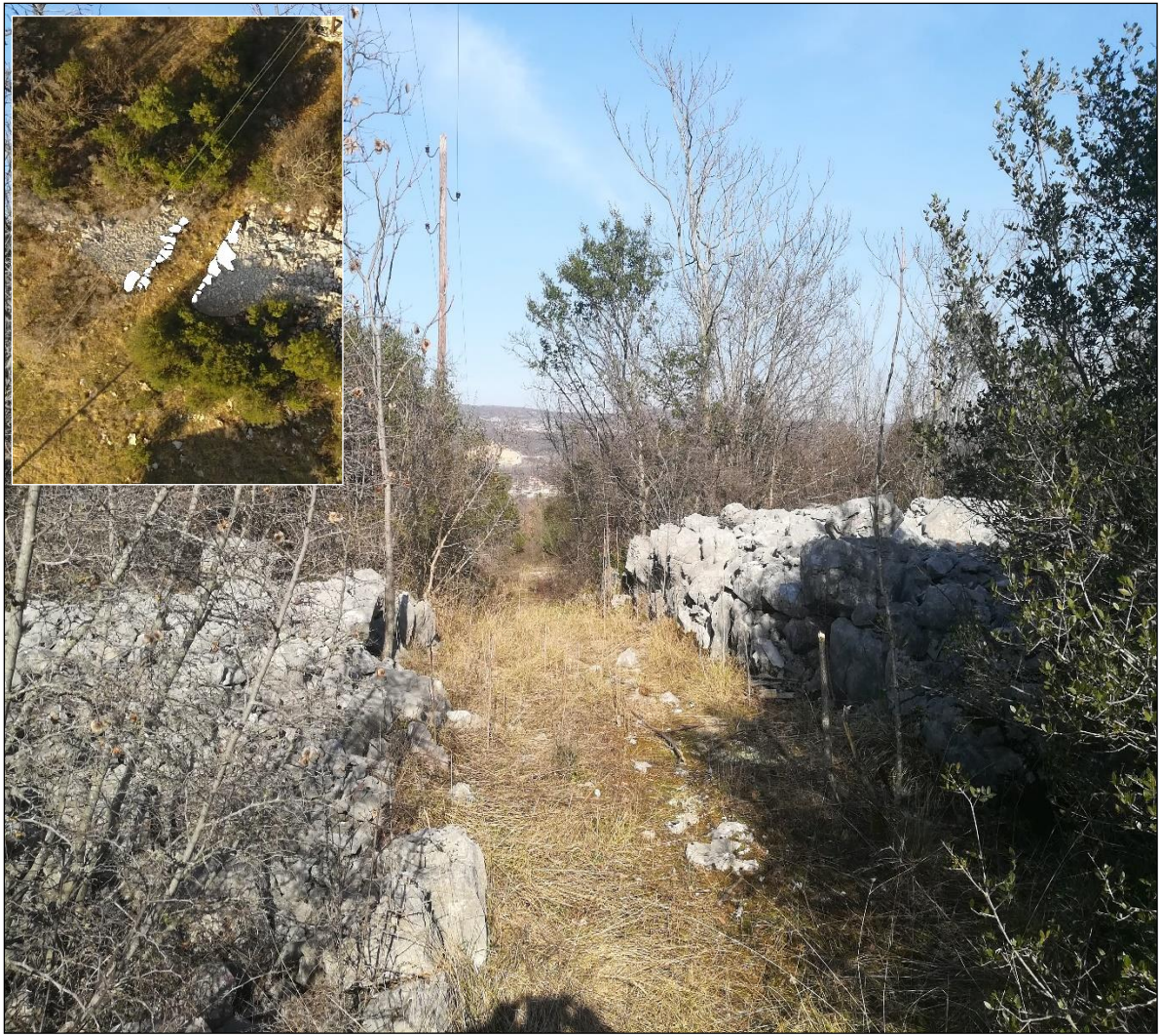
Sl. 275. Ulaz na gradinu Samograd (foto: T. Tomas)
