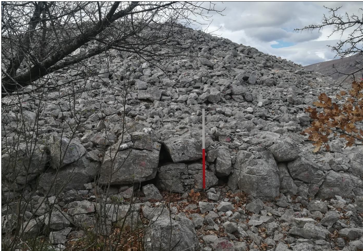
Sl. 65. Vanjsko lice bedema, složeno od krupnijeg kamena (foto: T. Tomas)
