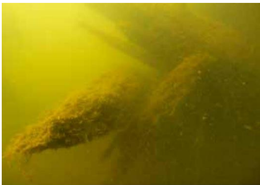
Slika 13. Ostatci pilona mosta u ribnjaku poslikani prilikom loše vidljivosti (M. PEŠIĆ, 2015, 12.).
