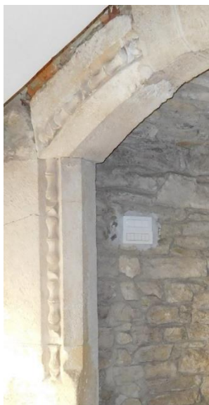
Slika 24: Varaždin, Stari grad – potkovasta kula: istočni zid, kameni okvir vrata, detalj s klesanim ukrasima (fotografija: Ivana Peškan)
