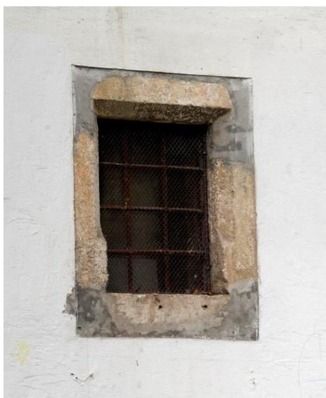
Slika 29: Varaždin, Stari grad, oružarnica – kameni okvir prozora (fotografija: Ivana Peškan)
