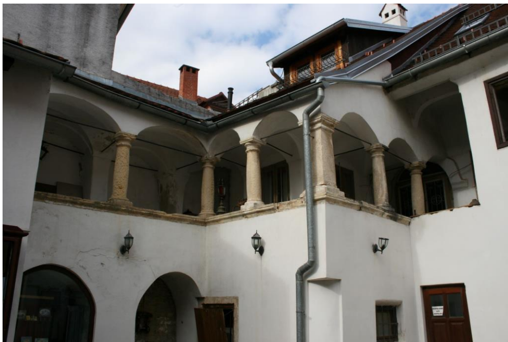
Slika 36: Varaždin, Franjevački trg 1 – kolonada na dvorišnom pročelju (fotografija: Ivana Peškan)
