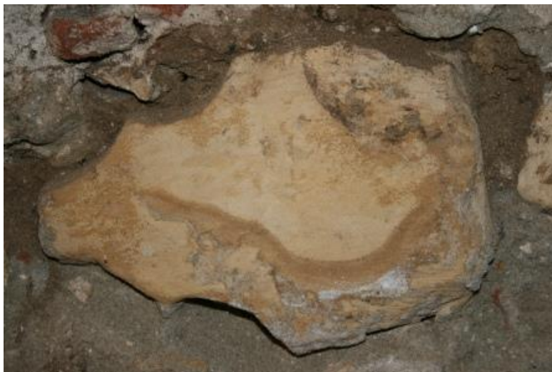
Slika 5: Varaždin, crkva sv. Nikole - svodno rebro (fotografija: Ivana Peškan)
