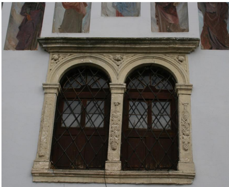
Slika 58 Radovec, župna crkva Uzvišenja sv. Križa, bifora na pročelju (fotografija: Ivana Peškan)
