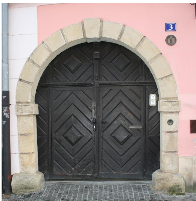
Slika 41: Varaždin, Franjevački trg 2 – portal kolnoga ulaza (fotografija: Ivana Peškan)
