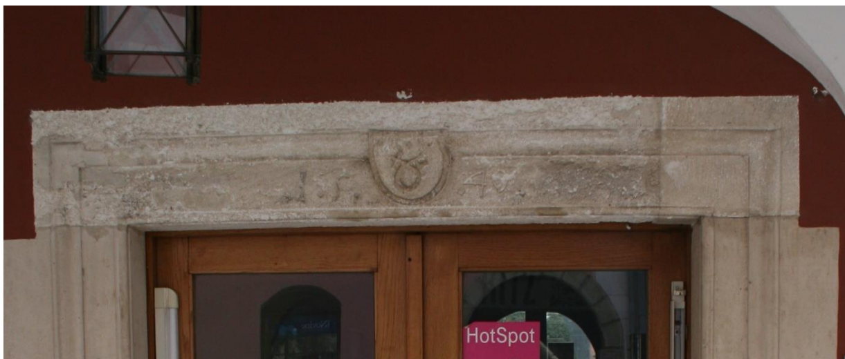
Slika 43: Varaždin, Trg kralja Tomislava 5 – kameni okvir vrata, nadvratnik (fotografija: Ivana Peškan)
