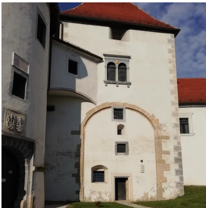
Slika 83 Varaždin, Stari grad, južna kvadratna kula, južno pročelje (fotografija: Ivana Peškan)
