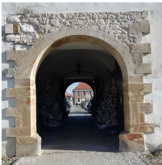
Slika 31: Varaždin, Stari grad, „Lančana kula“ – portal, zapadna strana (fotografija: Ivana Peškan)
